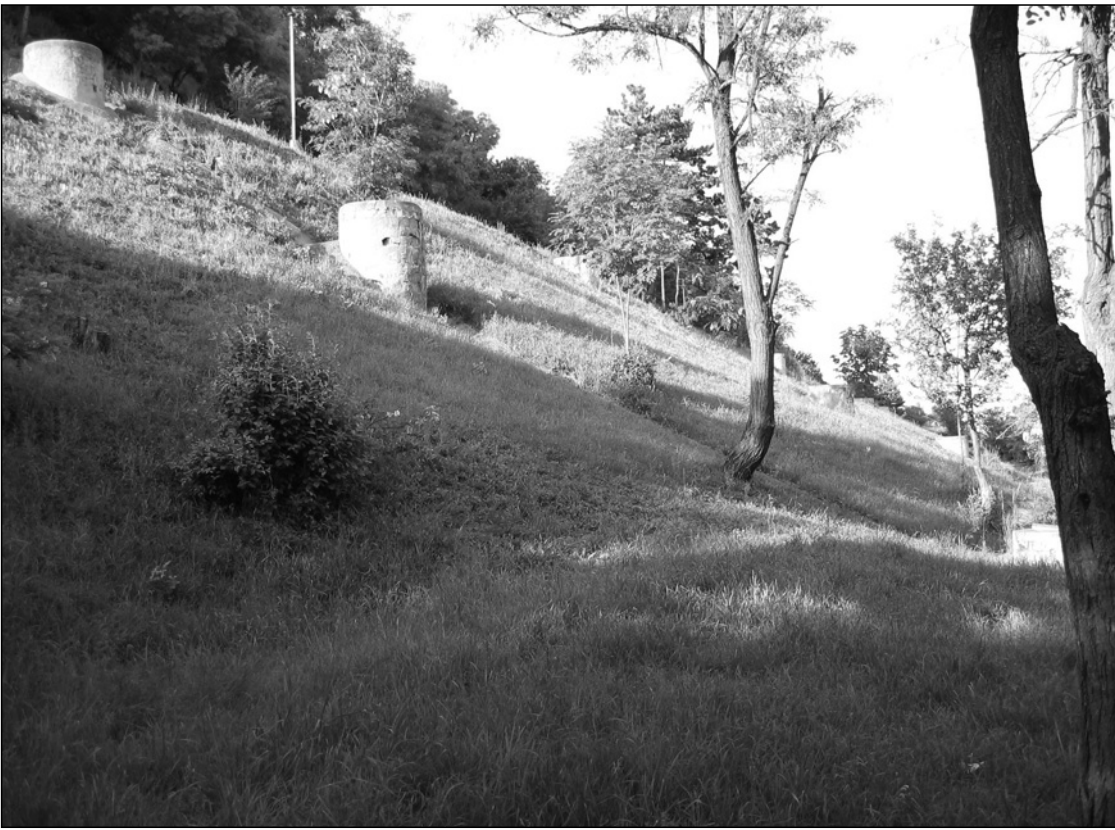
Meggörbült törzsű fák és rétegszellőztető betongyűrűk a Kőmál oldalában
