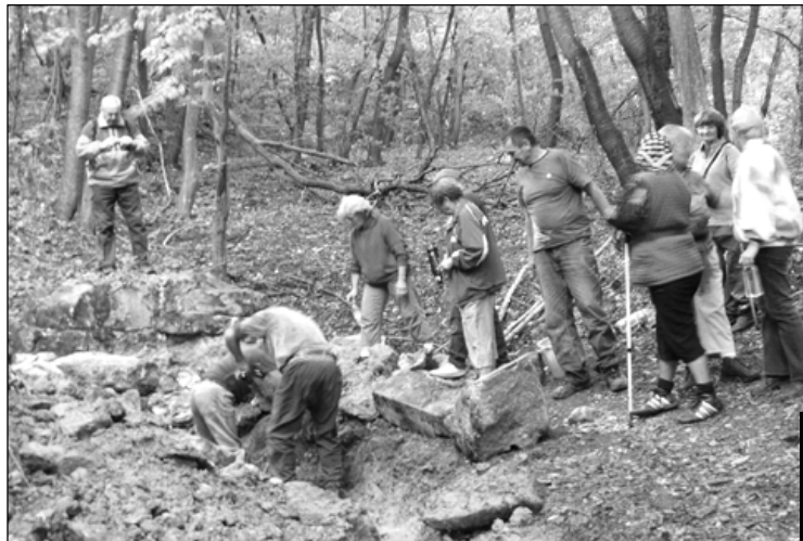
AZ EKE-forrás újjáépítése
